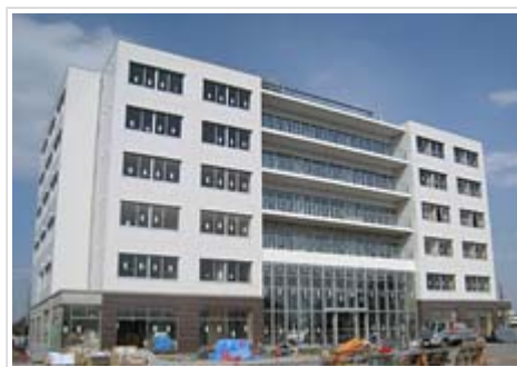
3月上旬に足場が取れたトワーム小江戸病院現場
