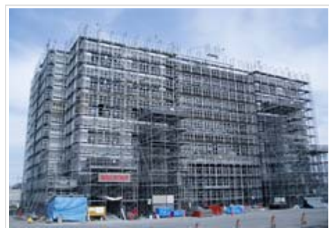
足場が取れる直前のトワーム小江戸病院現場
